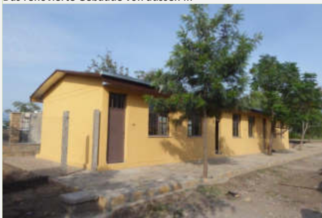
Das renovierte Gebäude von aussen ...
